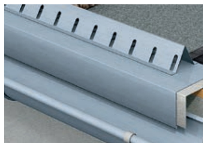
Skizze 40: Dachrand mit Kiesleiste
