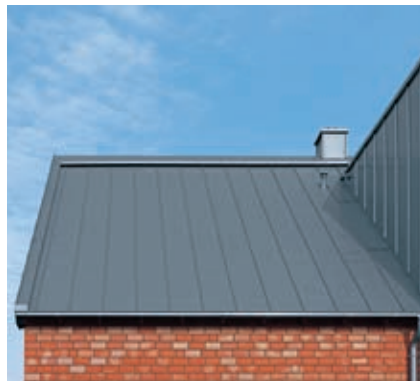
Stehfalzdeckung mit schmaler Giebelabdeckung und Lüfterfirst
