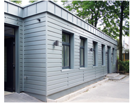
Bürogebäude, Hamburg, Deutschland
