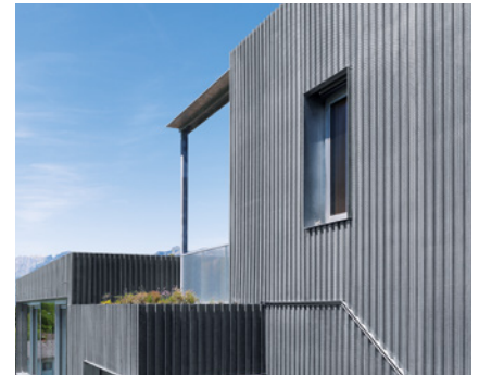
SHV SullnerHaus Vorarlberg, Sulz, Österreich
